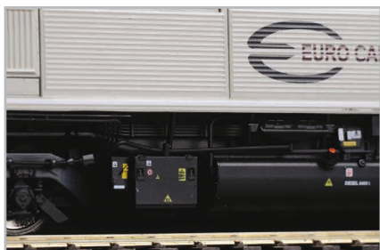
Compartiment à batteries
